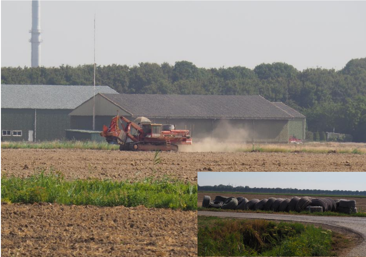
Fig. 5.1: Aanleg van buisdrainage in het stroomgebied van het Molenkreek-complex (7 augustus 2018). Kleine foto: opgerolde buisdrainage.
