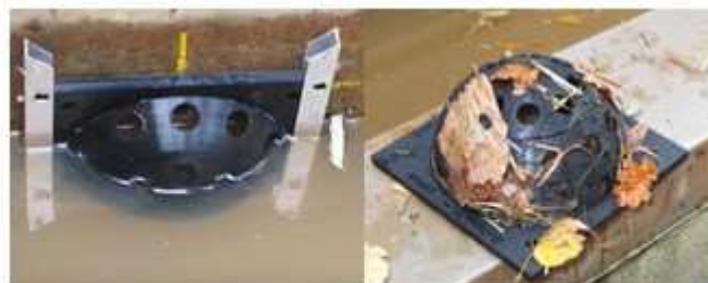
De goflow: innoveren door samenwerking. Minder wateroverlast door minder verstopping van kleine stuwten, mogelijk later met bioplastics via een 3D-printer te produceren.
