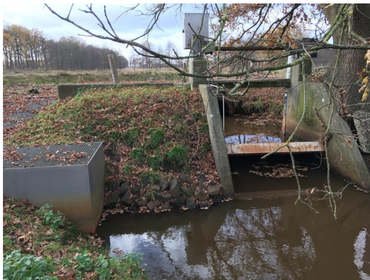
Figuur 2.11. Uniform traject 4 in benedenstroomse richting vanaf de Sintelweg op 25 april 2016 (links) en verdeelwerk Hellegat met aan de linkerkant de vispassage op 30 november 2018 (rechts).
