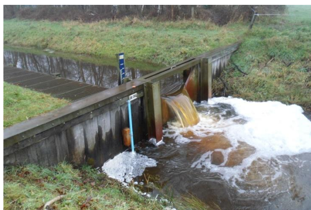
Figuur 2.5. V-vormige overlaat van vispassage in Bijlooppark op 31 januari 2006 (links) en De Witvispassage plus stuw in de Bijloop bovenstrooms van Ettensebaan bij hoge afvoer op 19 december 2012 (rechts).
