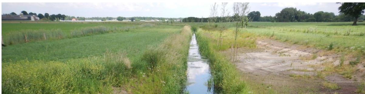
Figuur 2.6. Uniform traject 3 stroomafwaarts van de Hazeldonksestraat met links een bufferstrook met onderhoudspad en rechts een plas-draszone met bereikbaarheidspad op 31 mei 2017.
