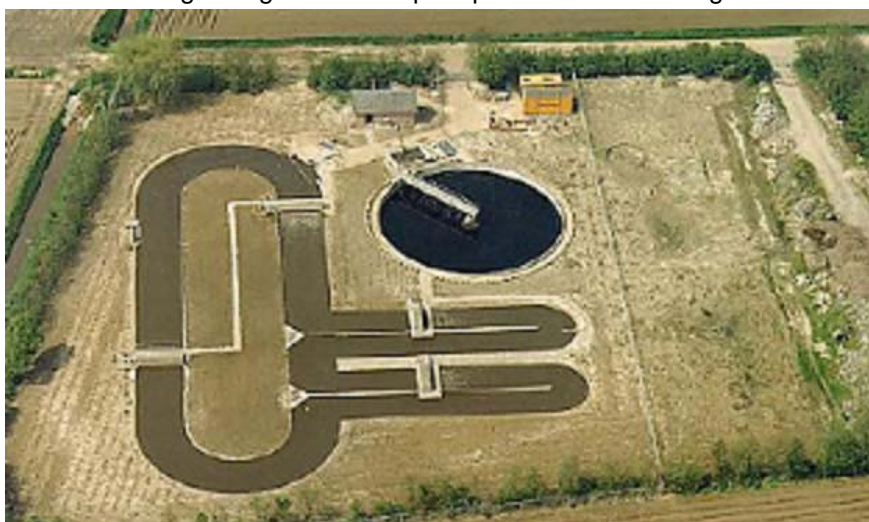
Figuur 3.2 Luchtfoto RWZI Ossendrecht uit 1985.
